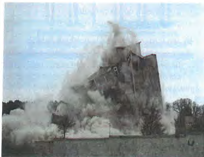
Derrumbamiento de un edificio provocado por la explosión de una bomba.
