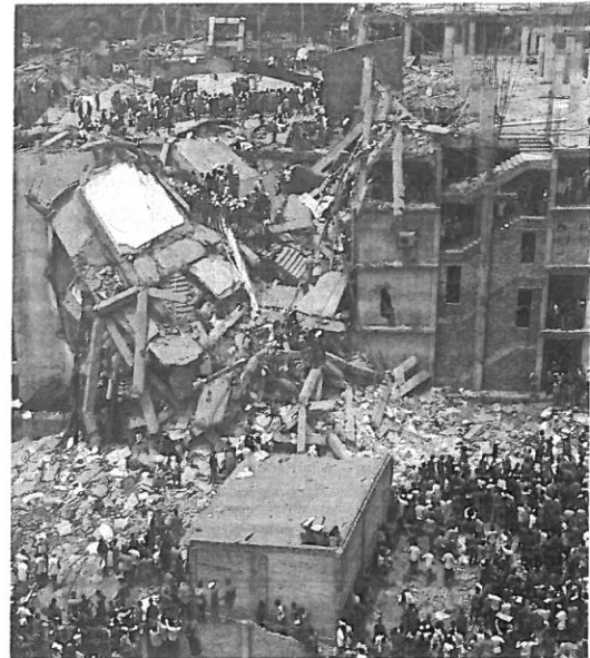
Edificio derrumbado en Savar (Bangladesh) en abril de 2013. Los directivos de las fábricas allí instaladas hicieron caso omiso de los avisos que anunciaban el colapso. Centenares de trabajadores, en su mayoría mujeres, perecieron o quedaron malheridos.
